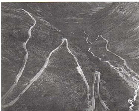
Figura 3.3: Foto do desenvolvimento de traçado em zigzague
