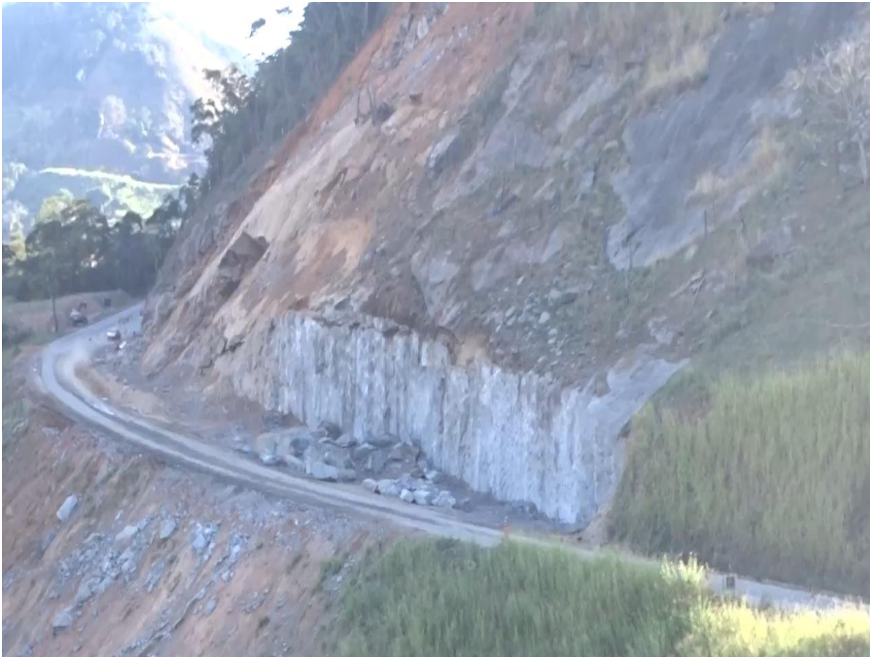
03_Explosão de rochas na BR-116 Jun-18
