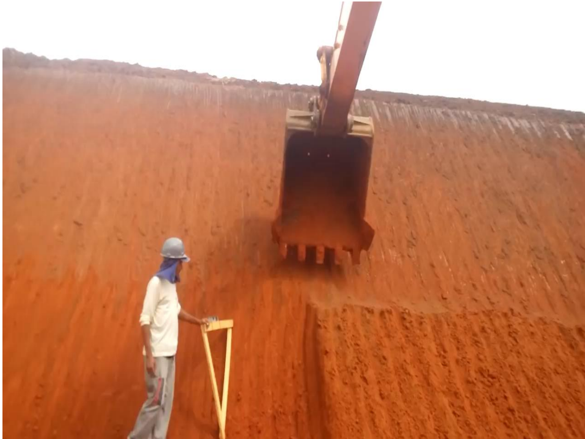
02_Fazendo Talude Terraplanagem
