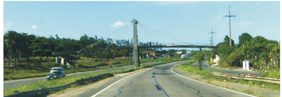
Passarela Estaiada – BR-101/PE
