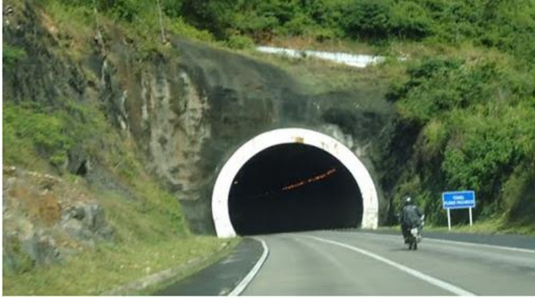
Túnel Cascavel – BR-232/PE
