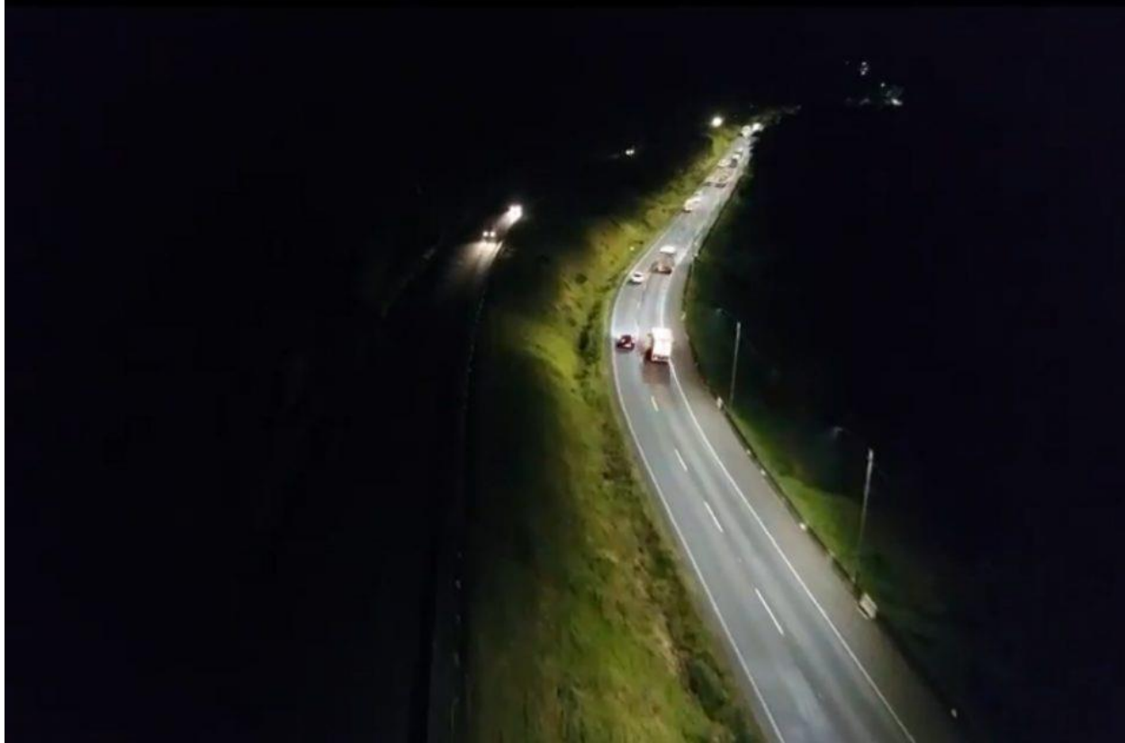
BR-376 - Iluminação na Serra do Mar - principal ligação de Curitiba com o Litoral de Santa Catarina
