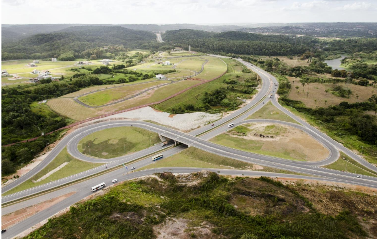
Interseção na Rodovia BR-408/PE - Latitude: 8° 0'22.17"S e Longitude: 35° 2'39.85"O
