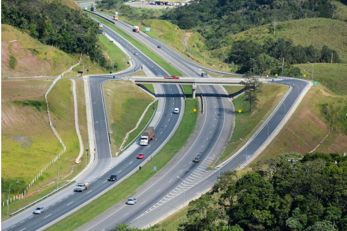
Interseção na Autopista Régis Bittencourt - BR-478/SP
