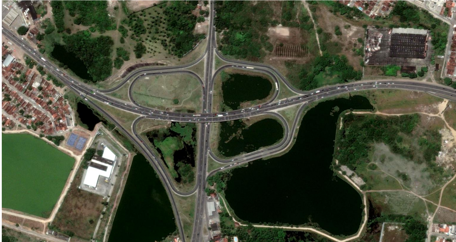
Entroncamento da BR-101/PB com a BR-230/PB - Latitude: 7° 9'56.31"S e Longitude: 34°53'47.75"O
