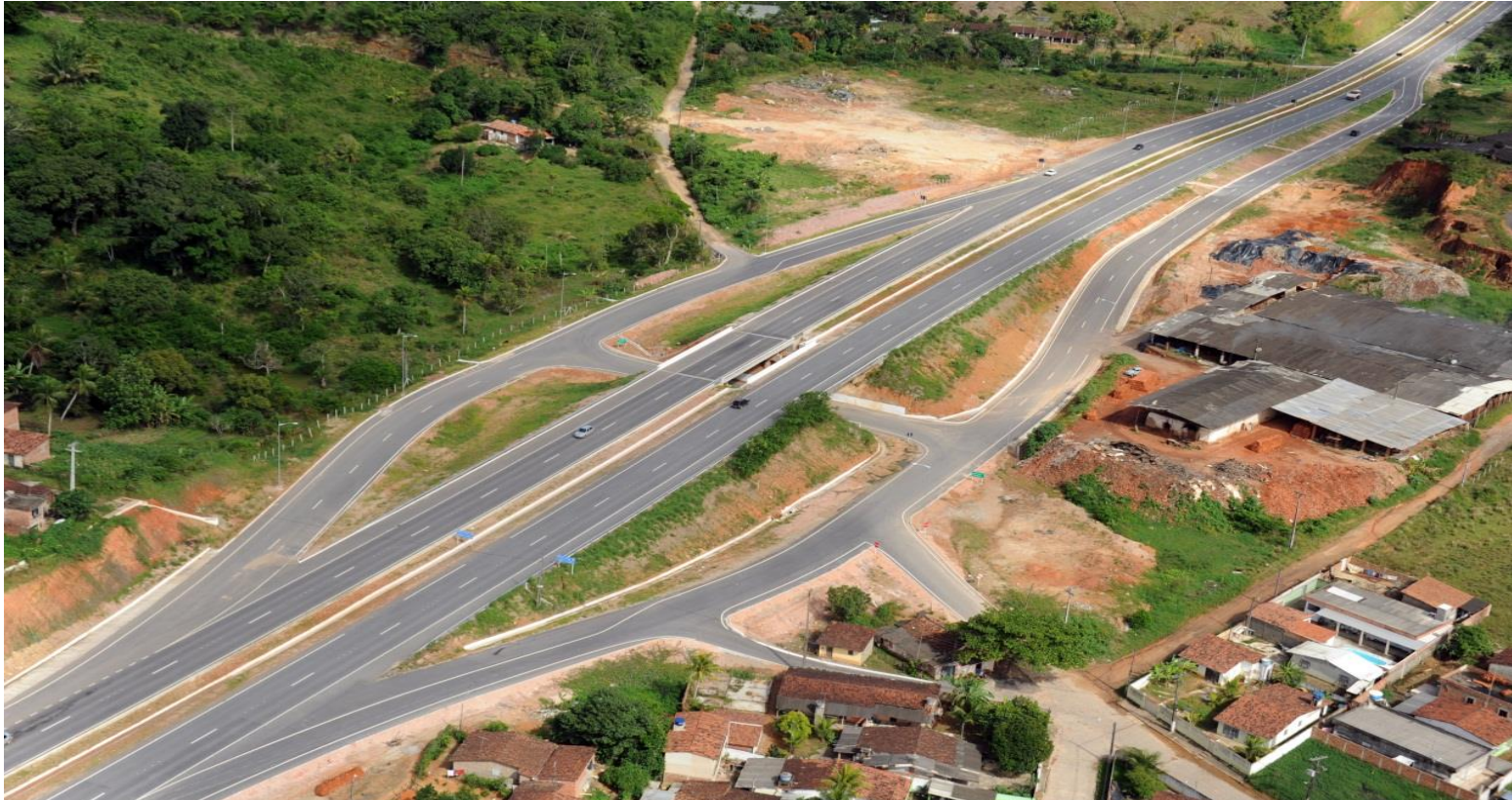
Interseção na Rodovia BR-408/PE - Latitude: 8° 0'11.03"S e Longitude: 35° 3'3.97"O
