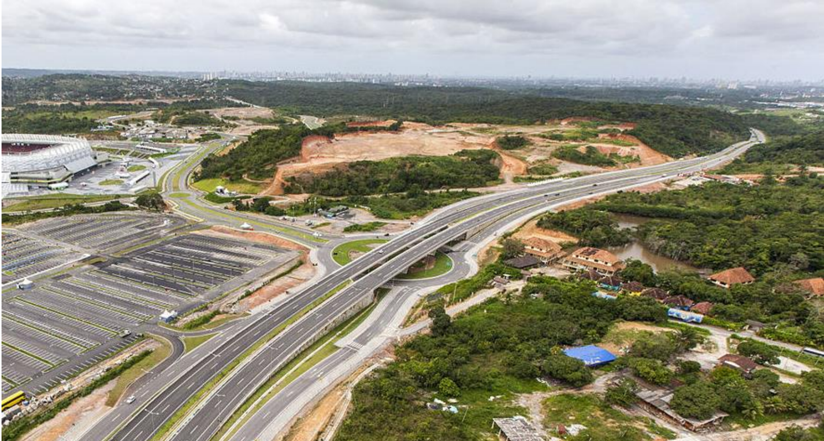
Interseção na Rodovia BR-408/PE - Latitude: 8° 0'22.17"S e Longitude: 35° 2'39.85"O
