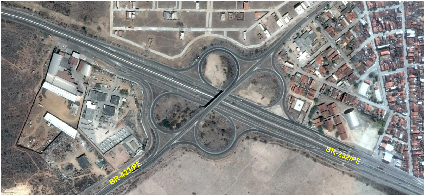
Interseção da BR-232/PE com a BR-423/PE- Latitude: 8°19'46.46"S e Longitude: 36° 8'48.02"O
