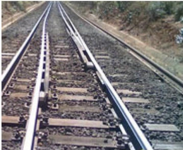
**Figura 144** - Alteração da bitola métrica em relação à bitola larga: de centralizada para à esquerda
