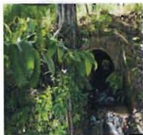
Presença de vegetação ocupando 100% da área da soleira e ao menos uma árvore
